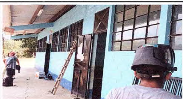
Foto 3: Medición a la previa colocación de balcones de las aulas
