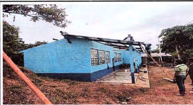
Foto 2: Inicio de colocación de láminas
