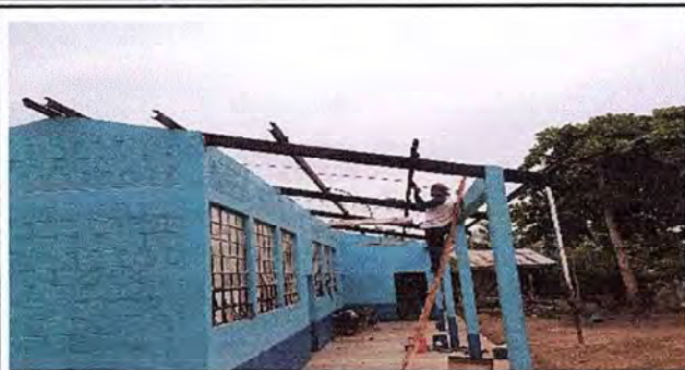
Foto 1: Limpieza de las costaneras de metal de las aulas en mal estado
