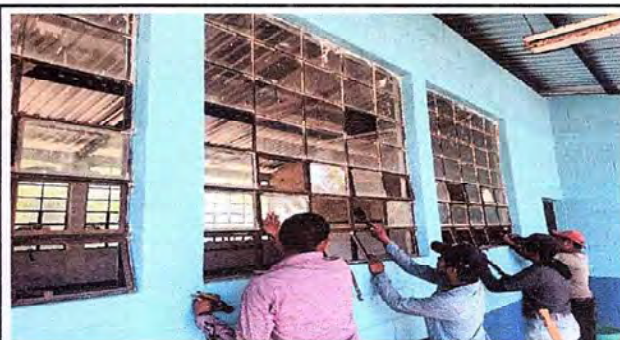
Foto 4: Limpieza y cambio de vidrios de las ventanass de aulas
